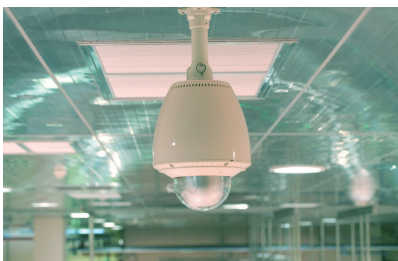
工場内の天井に取り付けられたプリセットコンビネーションネットワークカメラ (DG-NS202A) 写真上はハウジング付き
